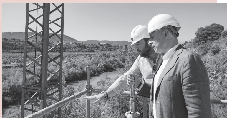
■ Escobar y López-Araquistáin en su visita a las obras.
