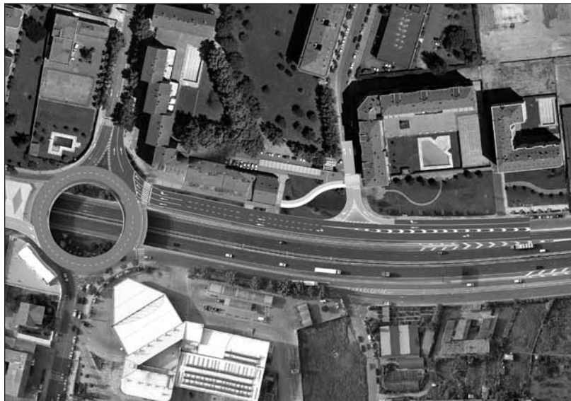
Recreación del resultado final de las obras en el entorno de la rotonda de Las Gaunas
